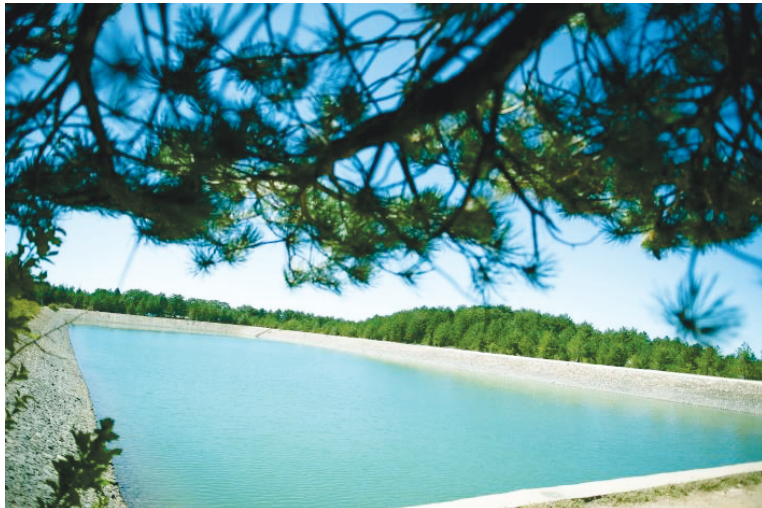
Υδατοφράκτης Πρόδρομου, Παιδαγωγικό Ινστιτούτου Κύπρου, Φωτ.: Θωμάς Καθλής
