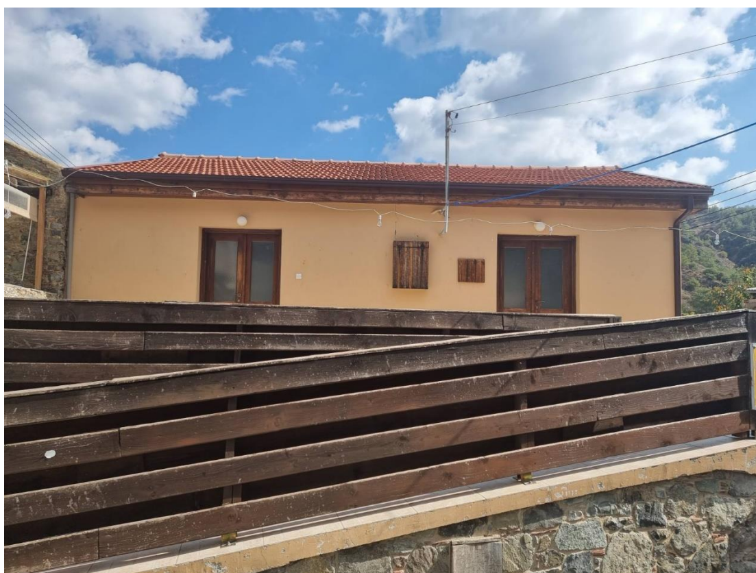
Εικόνα 20. Το υπό κατασκευή Κέντρο Ενημέρωσης και το Εργαστήρι Γαστρονομίας του Οικομουσείου στις Τρεις Ελιές
