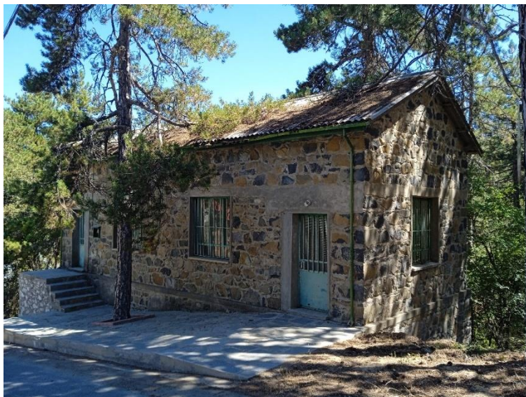
Εικόνα 19. Το κτήριο που θα στεγαστεί το Κέντρο Πληροφόρησης του Οικομουσείου
