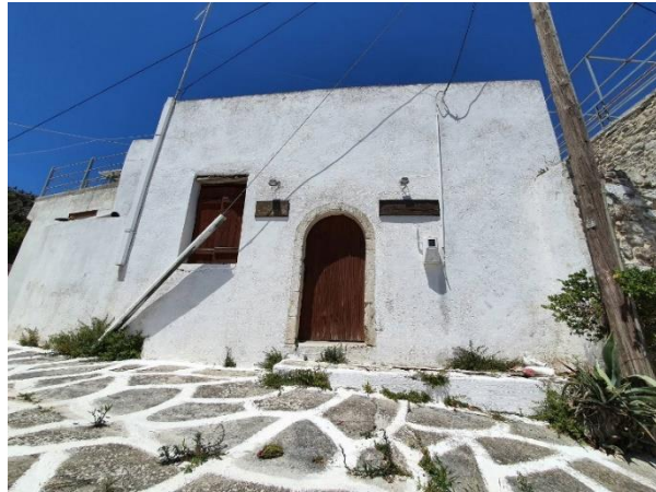
Εικόνα 7. Το Κτίριο του Ελαιουργείου στη Μαρωνιά
